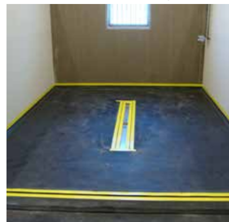
Einbau Waschplatz Belag
