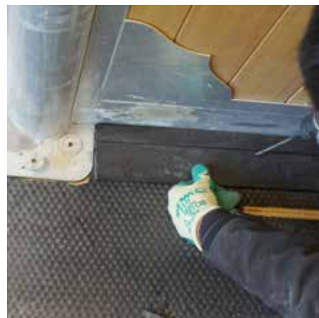
Montage der Gummiwinkel
