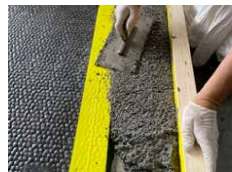
Ausgiessen der Ränder mit Gummigranulat.
