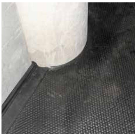
Wandabschlüsse mit Kitt
