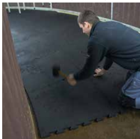
Einbau Führanlage-Belag
