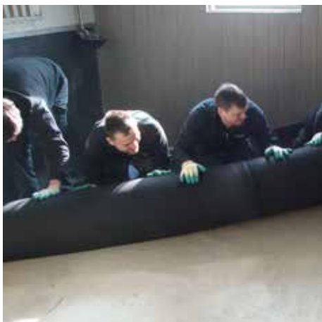
Auslegen Rollenmatte in der Box
