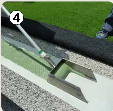
4 Verkleben des Rasens
