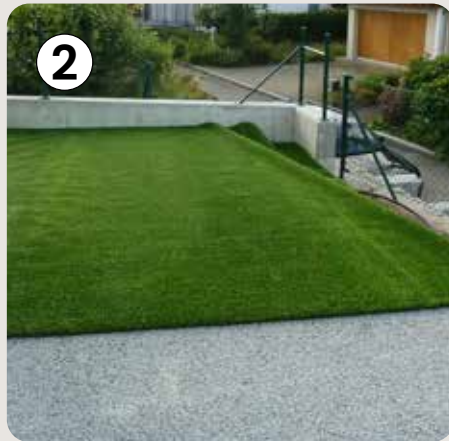
2 Ausrollen des Rasens
