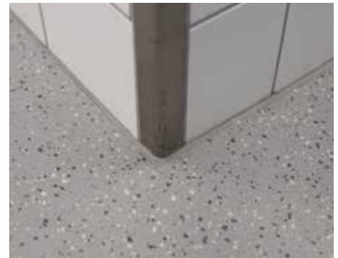
Urin- und wasserdichte Fugen
