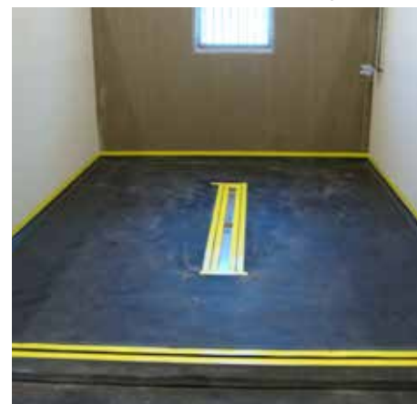
Préparations l'aire de lavage
