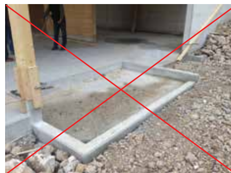
Les WC pour chevaux traditionnels en béton coulé sont inflexibles et chers en raison de frais de coffrage élevés.
