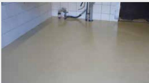
Eine weitere Besonderheit ist die sehr schnelle Montage. Der PU-Mörtel kann in einem Tag montiert werden und ist danach bereits nach wenigen Tagen einsatzbereit. Lange Wartezeiten entfallen.
