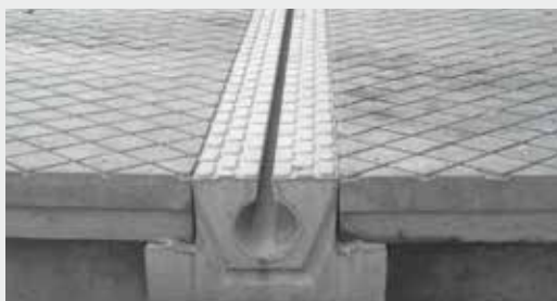
Laufgangplatten mit Schieberentwässerungsrinne
