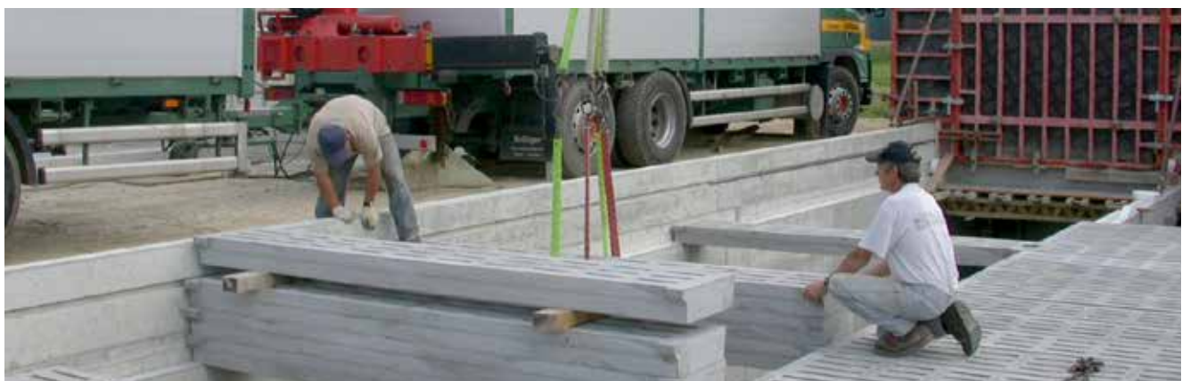
Lieferung durch Schmidiger Betonelemente AG
