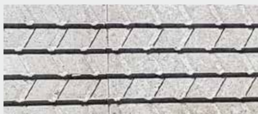
Klauenschonendes Rautenmuster mit Längsrillen für einen trockenen Boden.
