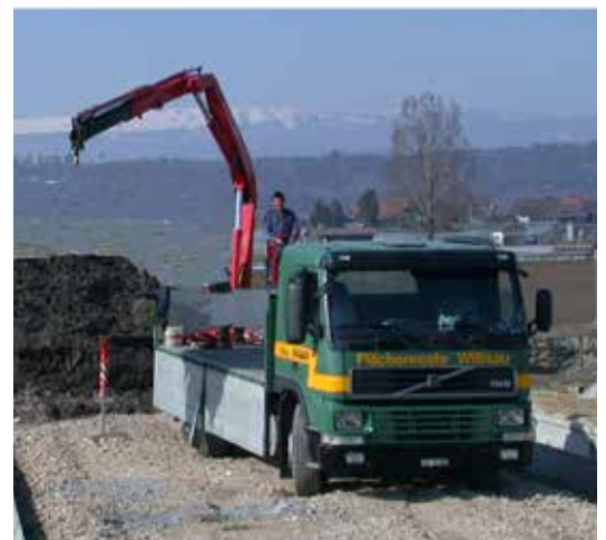
Lieferung durch Schmidiger Betonelemente AG
