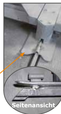
Breite Auflage für Mittelbock, Rundeisen angeschweißt
