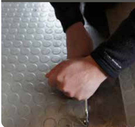
Pose de NORAMENT
