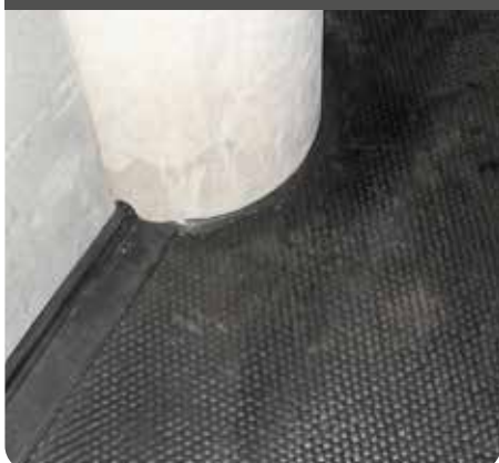
Finitions pour parois avec mastic et angle
