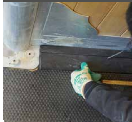
Pose des angles en caoutchouc
