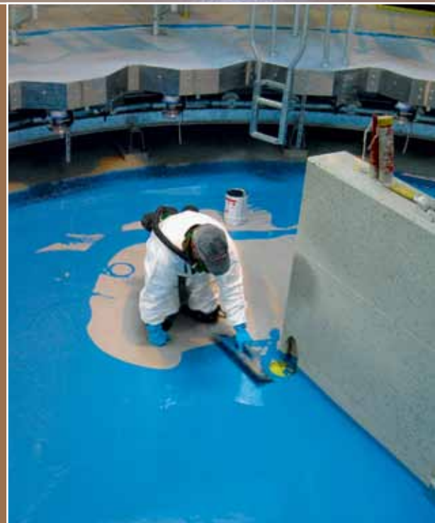
Pose du revêtement à répancre Vencomat EPO
