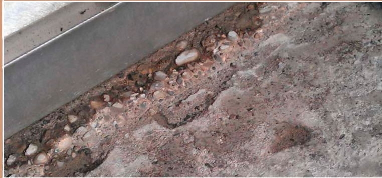
Von Säuren zerfressener Auslauf.
