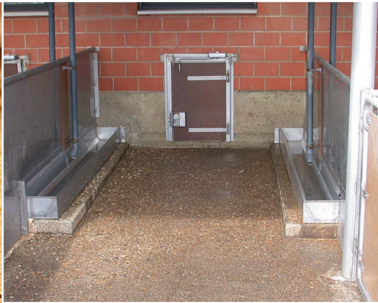
Vorher: Von Futtersäure verressener Betonboden.
