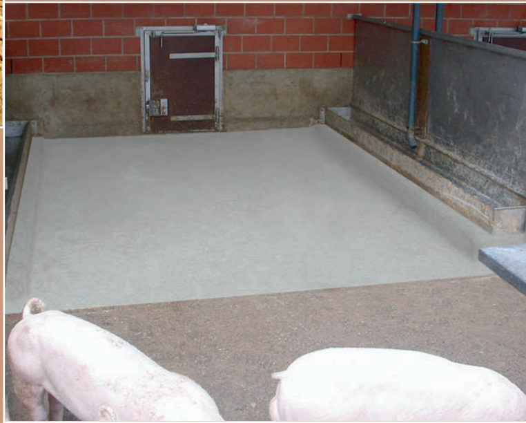
Nachher: Boden beschichtet und dauerhaft geschützt.
