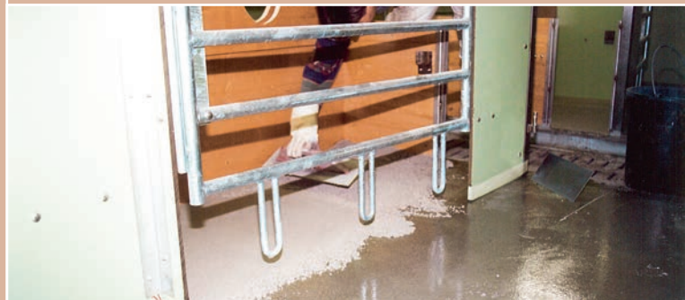
Einbau des Vencomat-Agro-Mörtel .
