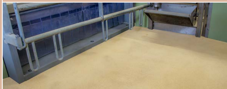
Mit Vencomat-Agro-Mörtel beschichteter Boden.
