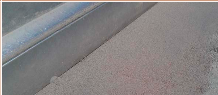
Auslauf nach Bodensanierung.
