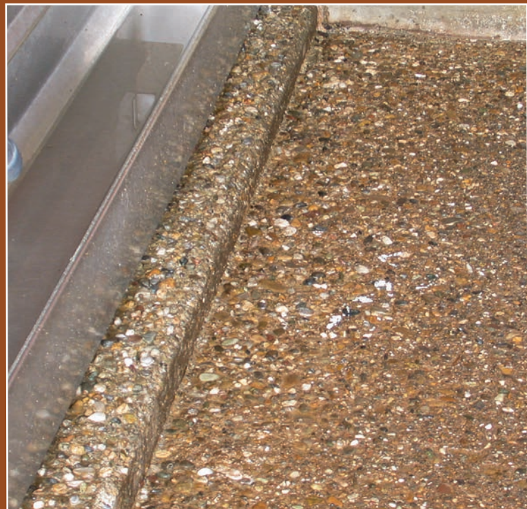
Ausgefressene Böden: Ein grosses Problem im Schweinestall.
