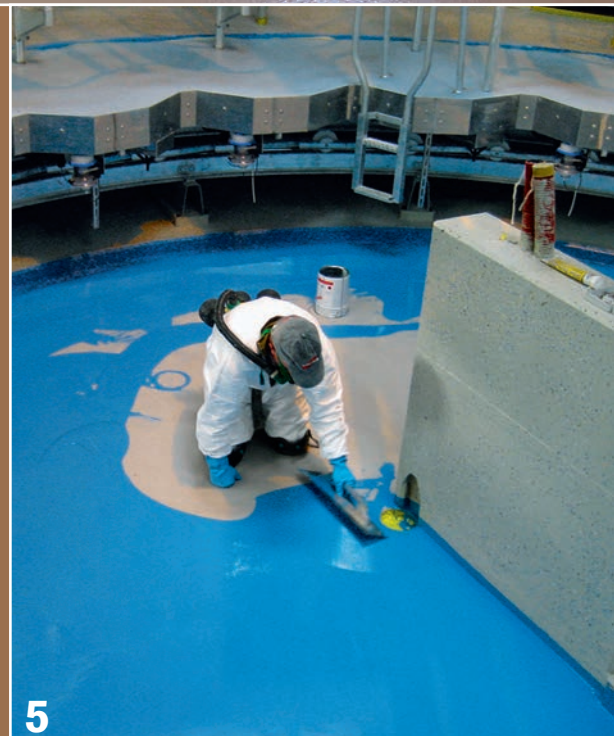
Einbau des Vencomat-Einstreubelages EPO
