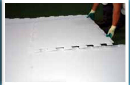
...mit umliegenden Platten verbinden.
