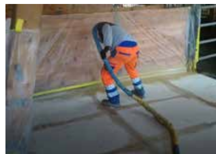
LES REVÊTEMENTS ELASTOSPRAY SONT APPLIQUÉS RAPIDEMENT ET SÈCHENT EN QUELQUES SECONDES.
