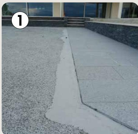
Béton avec gravillons & lit de mortier
