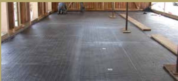
Beliebig grosse Flächen Urin- und Wasserdicht verlegt
