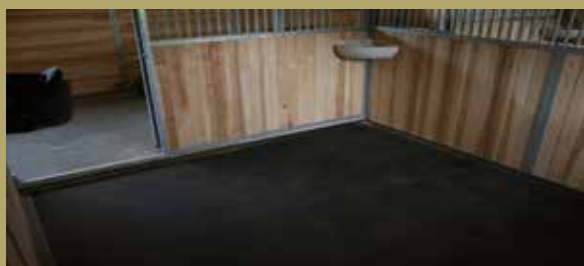
Gummimatte Thermo Grande in der Box verlegt
