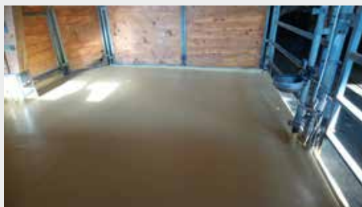
ELASTOSPRAY BESCHICHTUNGS KOMFORTSYSTEME SIND WEICH WIE EINE GUMMIMATTE UND ROBUST WIE EINE BODENBESCHICHTUNG
