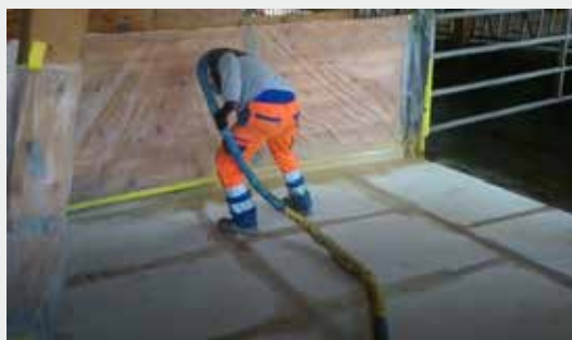
ELASTOSPRAY BESCHICHTUNGEN SIND SCHNELL MONTIERT UND IN SEKUNDEN TROCKEN.
