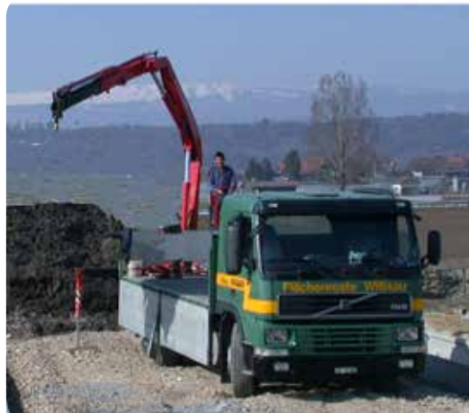
Lieferung durch Schmidiger Betonelemente AG
