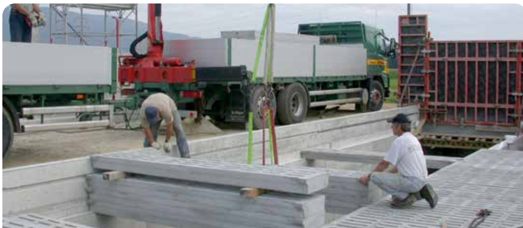
Lieferung durch Schmidiger Betonelemente AG
