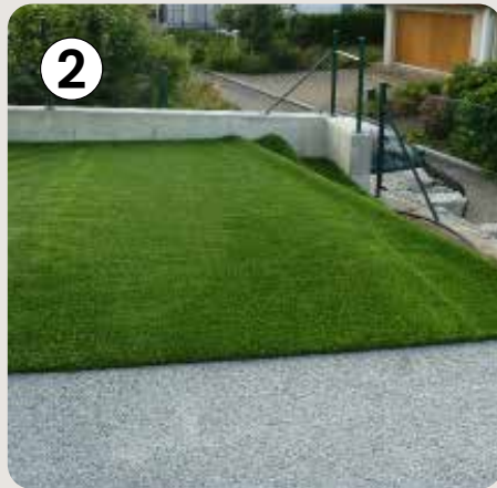
Ausrollen des Rasens
