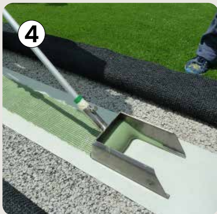
Verkleben des Rasens
